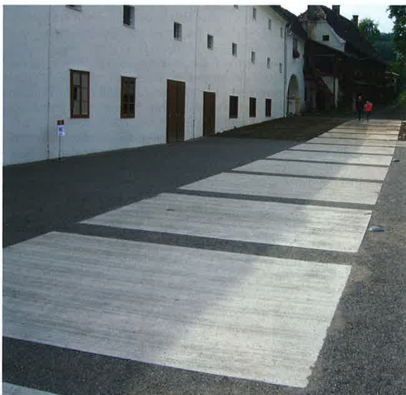
Naturparkzentrum Grottenhof in Kaindorf/Sulm, Planung: Arch. Max Stoisser Großflächige Betonfelder markieren den Zugang.
