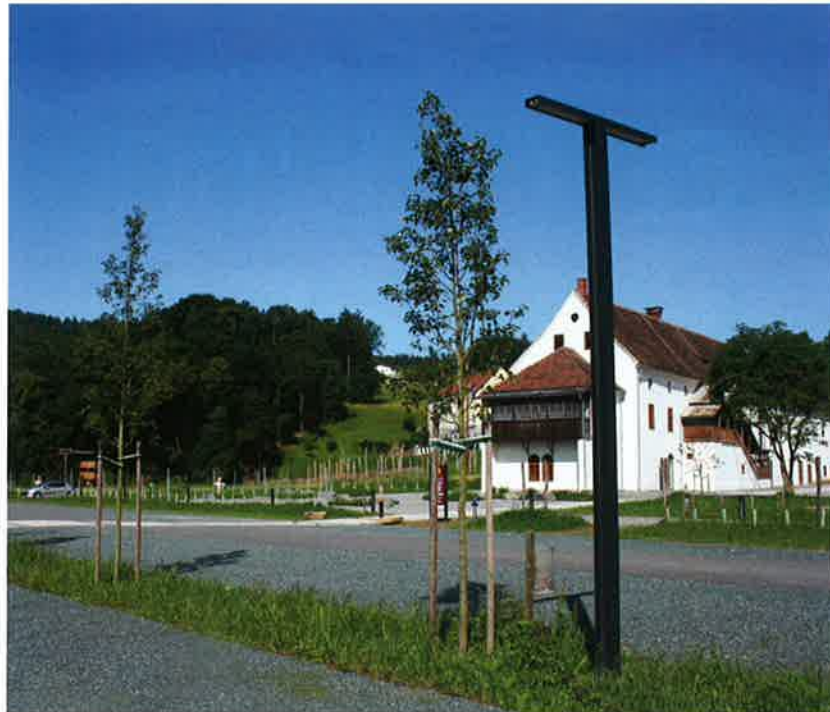
Naturparkzentrum Grottenhof in Kaindorf/Sulm, Planung: Arch. Max Stoisser Naturnaher, kaum versiegelter Großparkplatz mit heimischer Bepflanzung.
