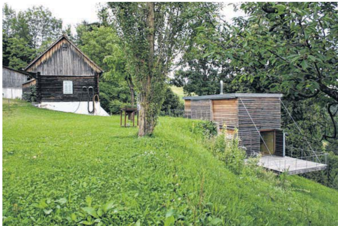
Qualitätsbewusstsein auch bei kleinen Bauvorhaben: Zubau Haus M. in Eichberg von Paul Katzberger
